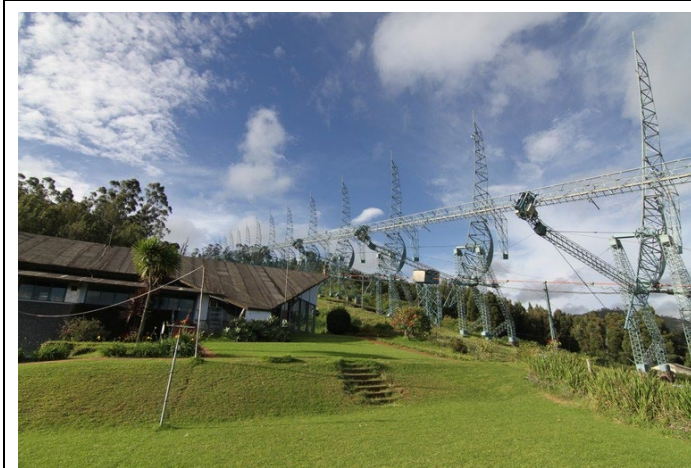
図 1 Ooty 観測所（駆動式のワイヤーメッシュアンテナである）飯館局との基線長は 6622km である。
